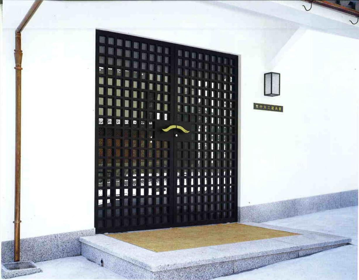
▲ソリッドの鉄材の欠き込みによって組み上げられた重量感のある扉（白壁造り風の建物、竹中大工道具館）
