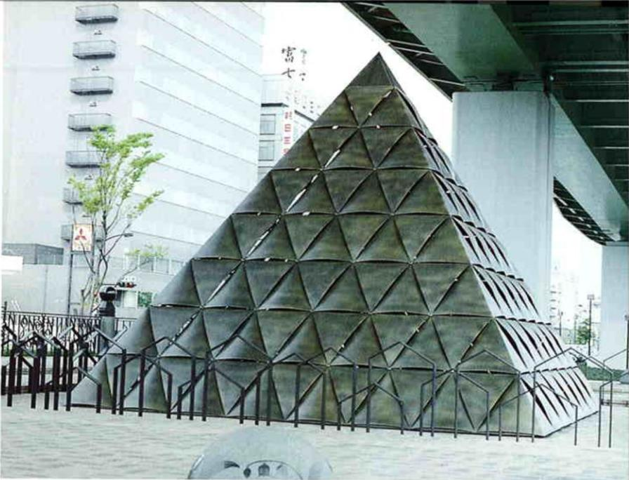
▲ これらのモニュメントは名古屋市の中心、高架道路の下に広がる長大な公園にあります。ピラミッドは内部に照明が仕掛けられ、光がスリットから外へ漏れ出る様に設計されました。表面はマタリコンで処理されています。左側は色々な動物のパターンのプレートで構成されたトーテムポールを意識したモニュメントです。アルミニウム材で製作し、表面はステンレスのマタリコンで処理されています。酸化ステンレスの珍しい色彩です。二対になっていて子供たちに人気があります。マタリコン処理は金属をプラズマの高熱で溶射する技法で、耐久性と同時に目的によって金属の色彩を求めることが出来ます。(若宮大通公園・名古屋市)
