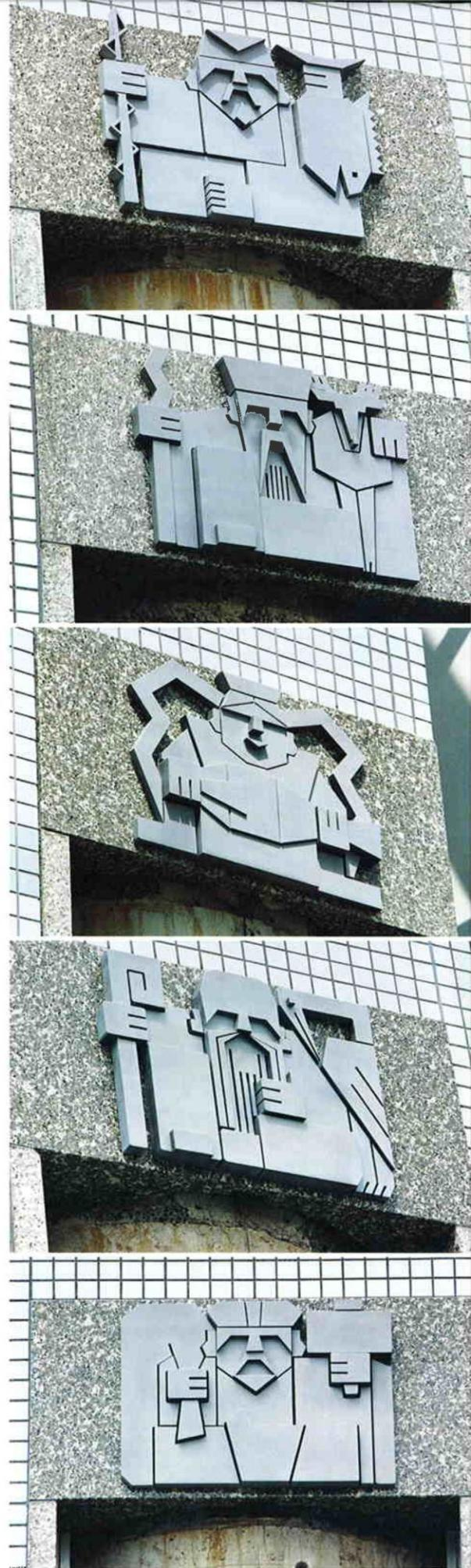
▲ アルミニウム基材に金属溶射によるレリーフ。
