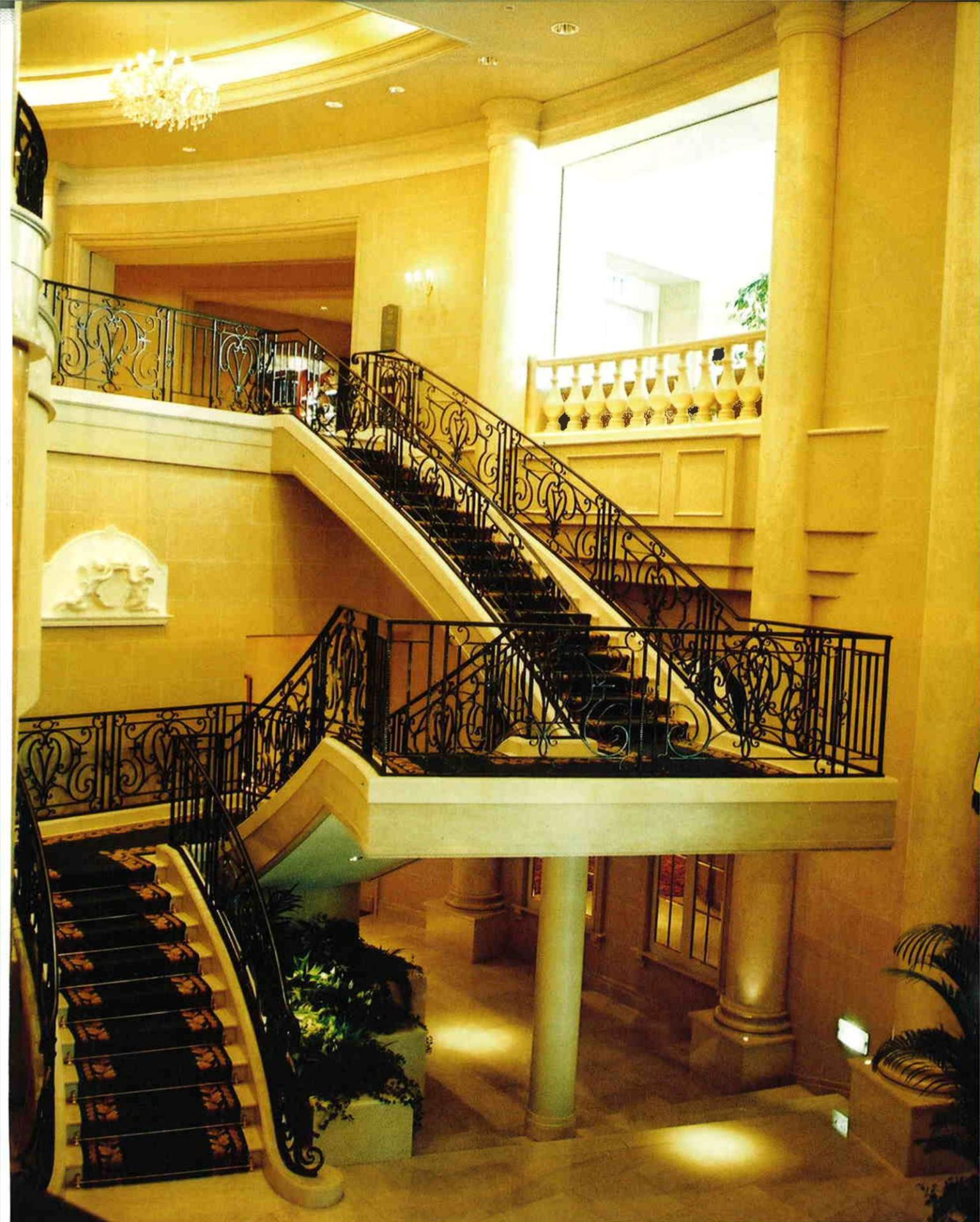
手摺りのデザインはフランスのルイ王朝時代の様式の中から選択し、典型的でイヤ味の無いデザインにアレンジされています。この階段は大きな吹き抜けのスペースの三層のフロアを機能的ににも、デザイン的にも繋ぐ役目を果たしています。このように複雑な形状の階段パネルのデザイン設計と製作施工は当社が最も経験とノウハウを発揮できる場面です。(ホテル グランパシフィック メリディアン・東京)
