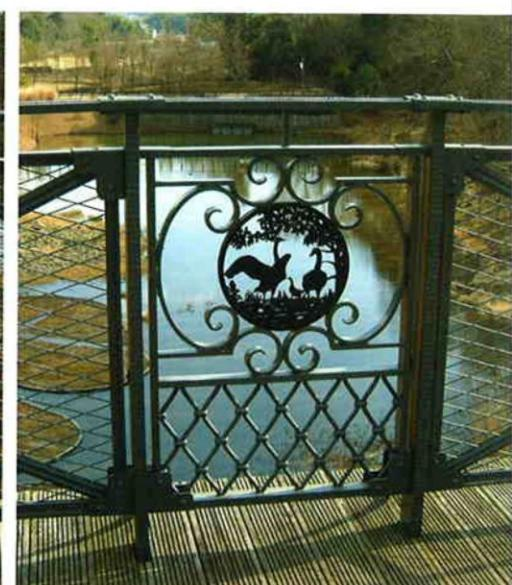
▲ 鉄の橋が造られ始めた頃の木の地板の橋のスタイルを復元したものです。これはアンデルセン公園のモニュメントとしての橋です。高欄にロートアイアンでアンデルセンの色々なテーマのサインを入れています。（アンデルセン公園・船橋市）
