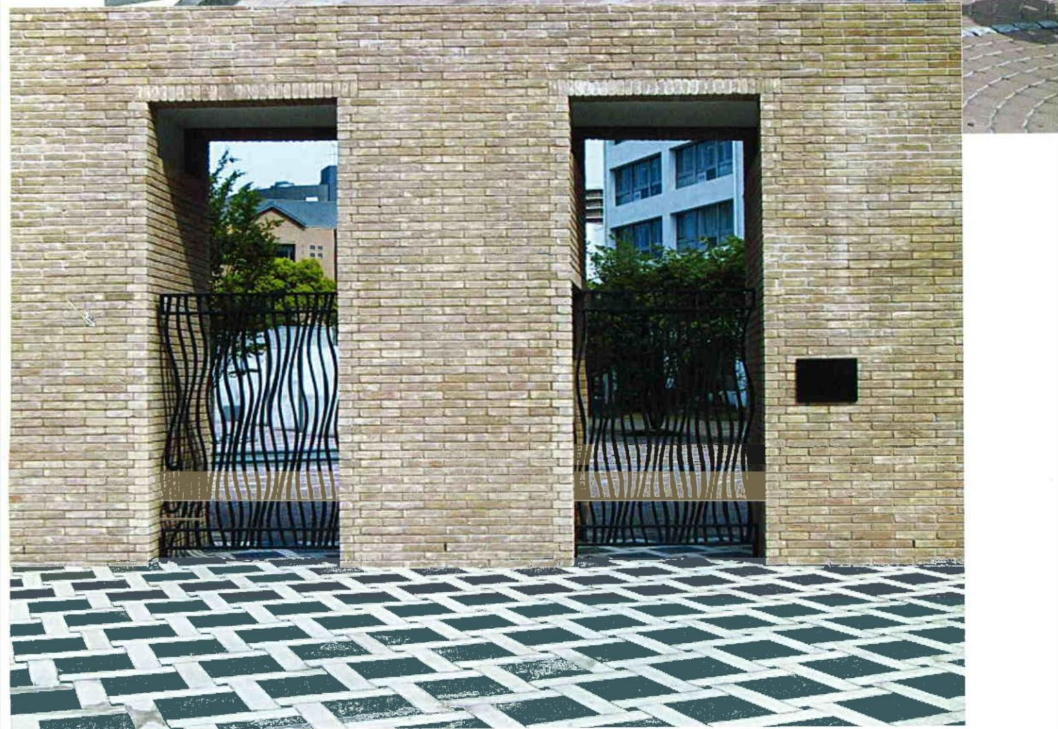
ロートアイアンによる線の表現の面白さを生かしたデザインの門扉、ソリッドの鉄線材を直接曲げることによって材質の力を運動のフォルムとして造形することが出来る、鋳造品では不可能です。（洗足学園・東京）
